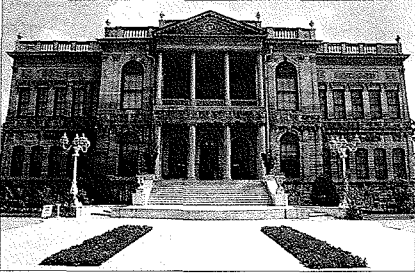
Dolmabahçe Sarayı'nın Mâbeyn Dairesi'nin ön cephesi
